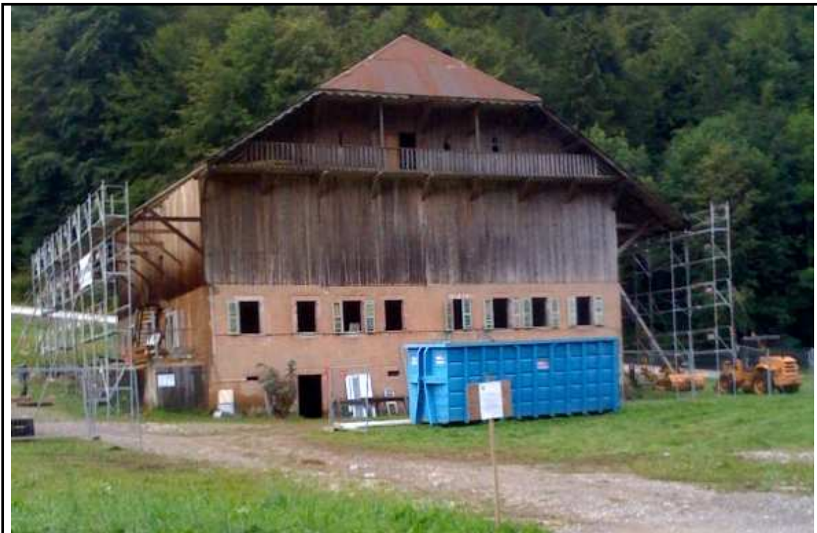
Illustration 5 : Le démontage d'une ancienne ferme savoyarde « qui gêne » les pistes de ski, et planche d'étude détaillée de cet habitat traditionnel en Savoie.
